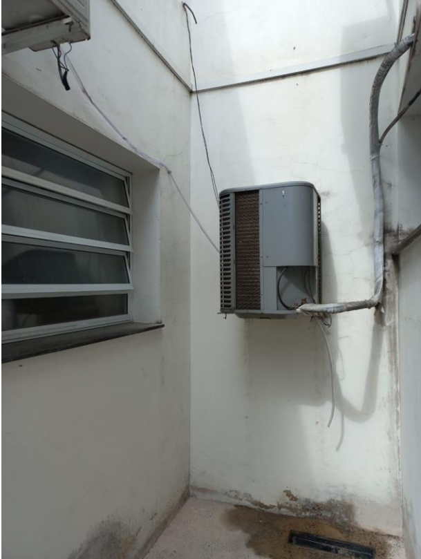
07/02 – Instalação mangueira de dreno do ar-condicionado, Farmácia satélite.
