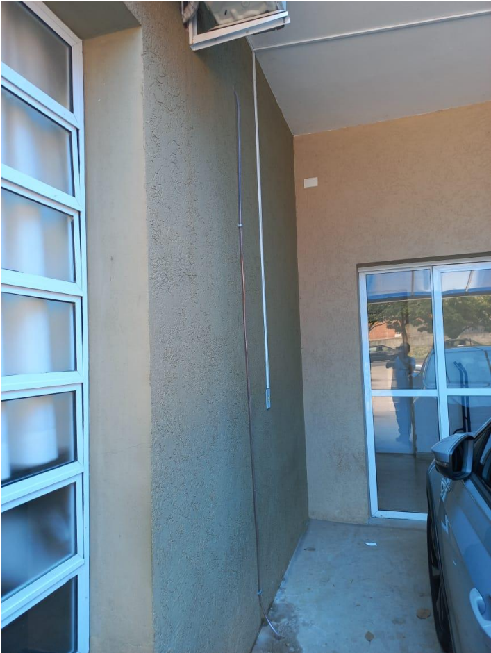
02/02 – Instalação de mangueira para dreno obstruído do ar-condicionado - sala administrativa
