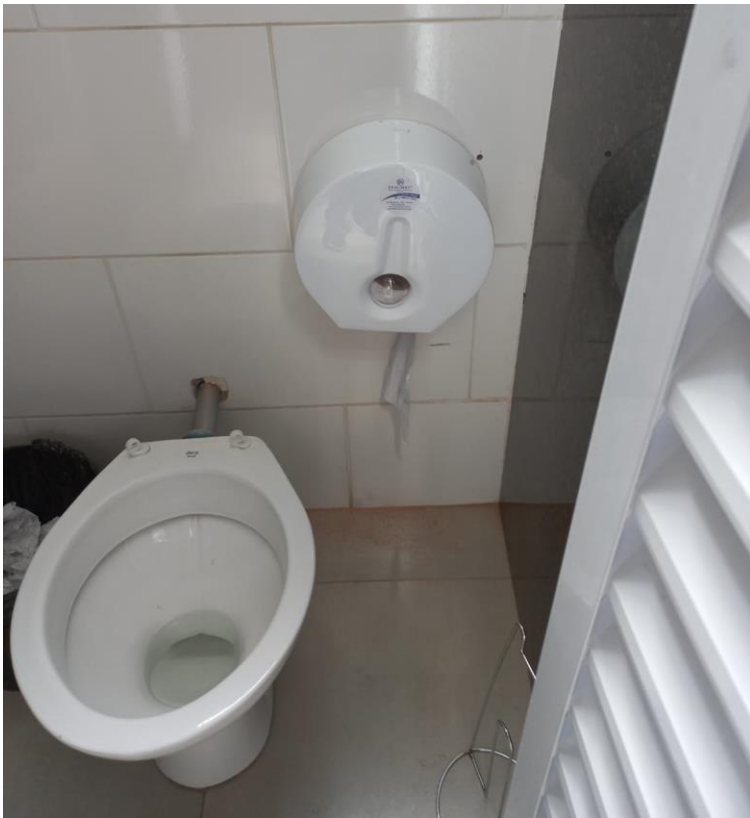
24/02 – Reforma do banheiro masculino e feminino, Recepção (ANTES)
