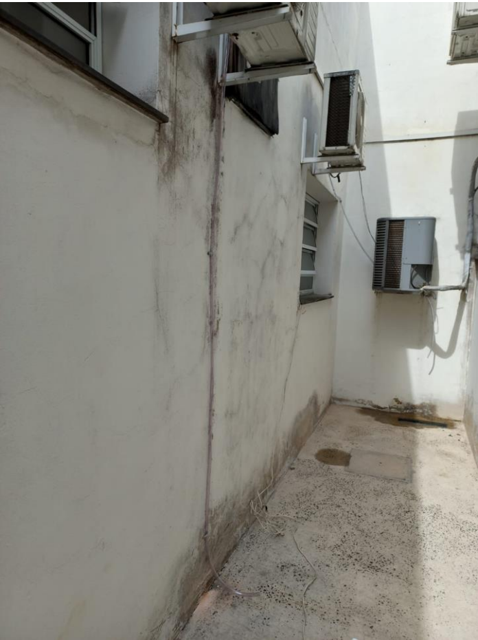
07/02 – Instalação da mangueira de dreno do 1º ar-condicionado Raio-X
