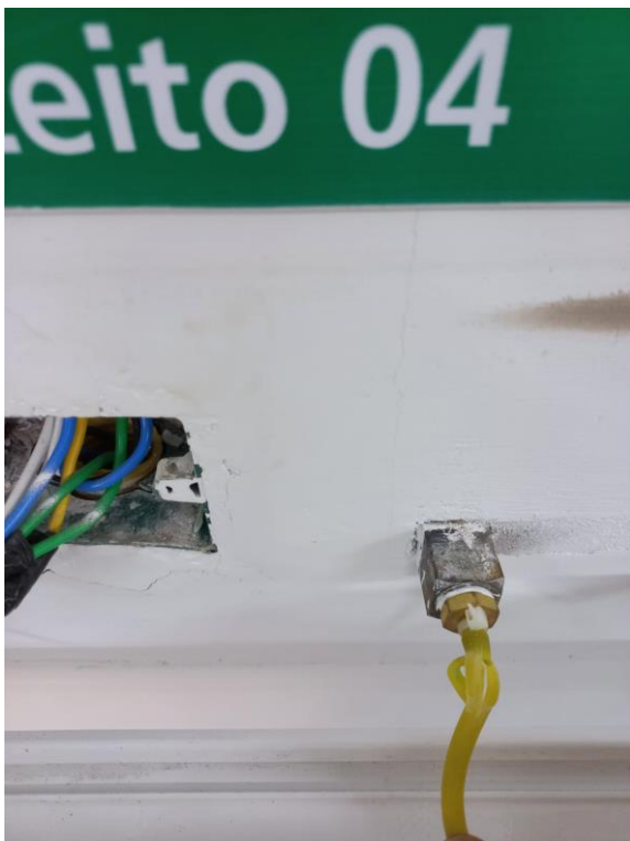
20/02 – Reparo mangueira danificada, leito 4, Observação
