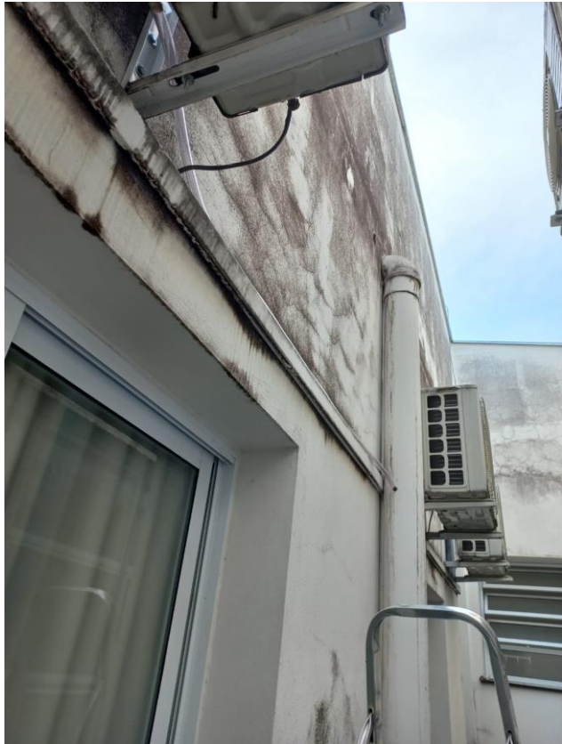
07/02 – Instalação da mangueira de dreno do ar-condicionado, Consultório 9.
